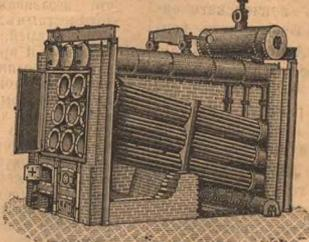
Котлы отличаются: простотою и прочностью конструкции, безопасностью въ работѣ, экономіею въ топливѣ, быстротою паропроизводства, сухостью пара и удобствомъ въ чисткѣ.
