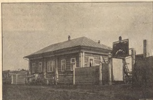
с. Камень. Склад машин Наружный вид.
