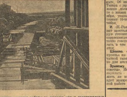
На Ушаеве в полном разгаре работы по установке новых водопроводных труб. На снимке — деревянный лоток, который во время замены дна Ушаев вынул.
