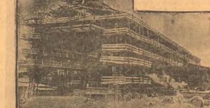
На Верхне-Исетском заводе (Свердловск) строится новый мощный металлургический цех. В цехе установлена 8-тонная электропечь, которая будет давать высококачественную сталь. На снимке: Новый цех в леску.
