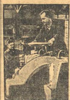
Тяжелый комбинированный портально-фрезерно-расточный агрегат в Серове. У станка стоит германский инженер, специально приглашенный для его монтажа и установки.
