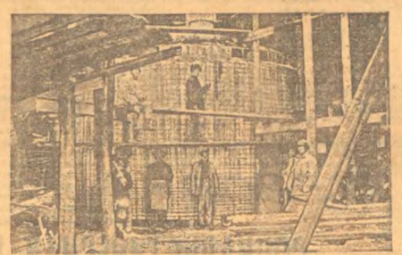
Кузнечий. Временный водорез калыхаям стеном надгорного рельефу
