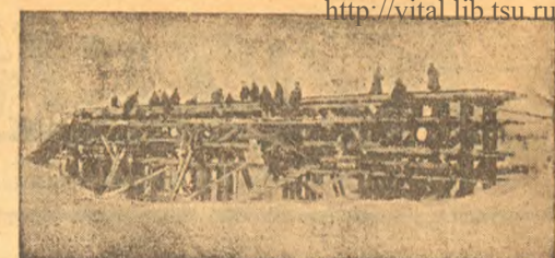
Томск-Енисейская, Сборка моста через р. Юшта.
