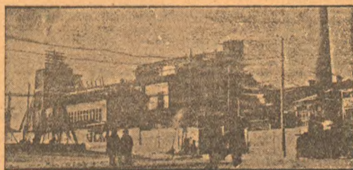
СТРОИМ БОЛЬШОЙ КУЗБАСС. В Анжеро-Судженске заканчиваются работы по расширению центральной электростанции.
