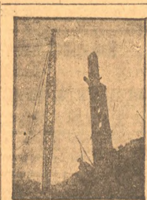
Кузнечистрой. Подъем стальной фермы на постройке мартеновского цеха
