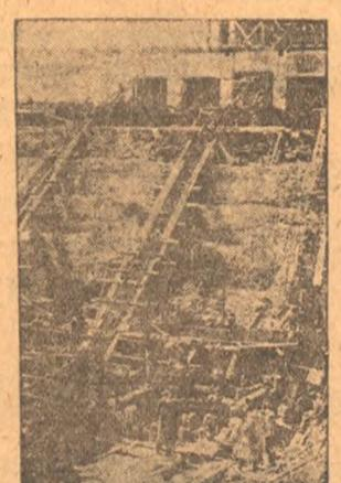
КУЗНЕЦСТРОЙ. На снимке момент окончания земляных работ на скреперной яме (котлован для руды и угля) дома № 2. Объем вырытой ямы — более 3000 кубометров в объеме. (Фото-бригада ОБВКФ).
