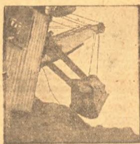
Сибкомбайнстрой Эскаватор «Марион» на работе по рытью котлован.
