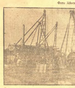
Шегловск. Шахта Шегловская I. Бурильщики для замораживания при проходе штета
