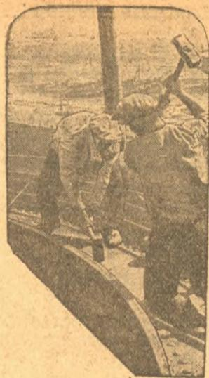
Клепка металлических конструкций домы на металлургическом заводе Днепрокомбината.
