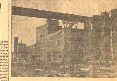
К 1 декабря текущего года в Кузбассе, в Кемерово, должен быть пущен второй мощный химвоз. На снимке: Главное здание завода. (С.Осипов)
