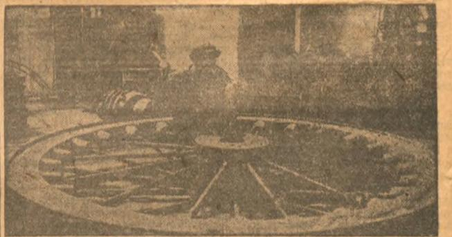
Завод «Металлист». Изготовлен шкиф для шахт Кузбасса.
