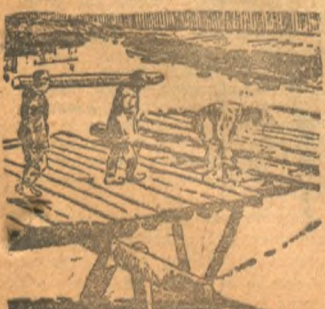
Ремонт грунтовых дорог. Постройка нового моста.
