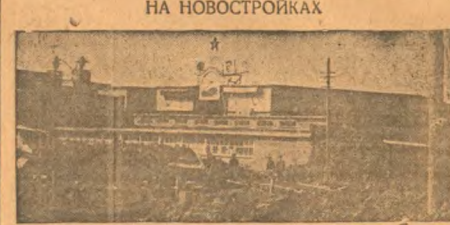
Пролетарский завод резиновых подошв. Занимается строительством в 4-м квартале.
