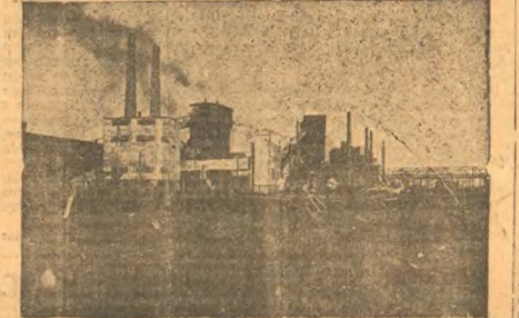
Музейный металлургического завода. Общий вид с сортировочной станции.
