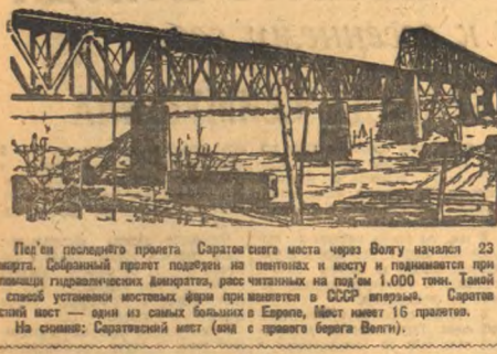
После окончания работ Саратовского моста через Волгу начался 23 марта. Собранный пролет подвешен на петлях и мосту и поднимается при помощи гидравлических домкратов, расставленных на полу 1.000 тонн. Такой способ установки мостовых пролетов при возведении в СССР впервые. Саратовский мост — один из самых больших в Европе. Мост имеет 16 пролетов. На снимке: Саратовский мост (он с правого берега Волги).
