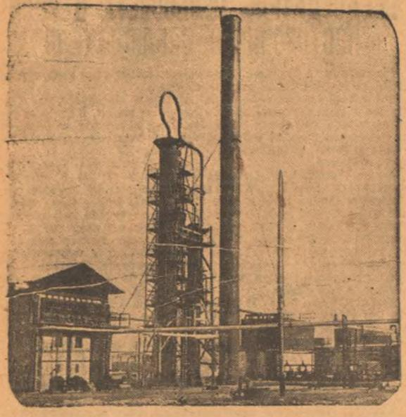
На Нефтедской горе (Туркмения) вырост первый в Средней Азии нефтеперерабатывающий завод. Первые дни пробного пуска показали, что агрегаты и аппаратура работают вполне удовлетворительно. Завод будет перерабатывать около 700 тонн нефти в сутки. На снимке: общий вид завода. (Скофето).
