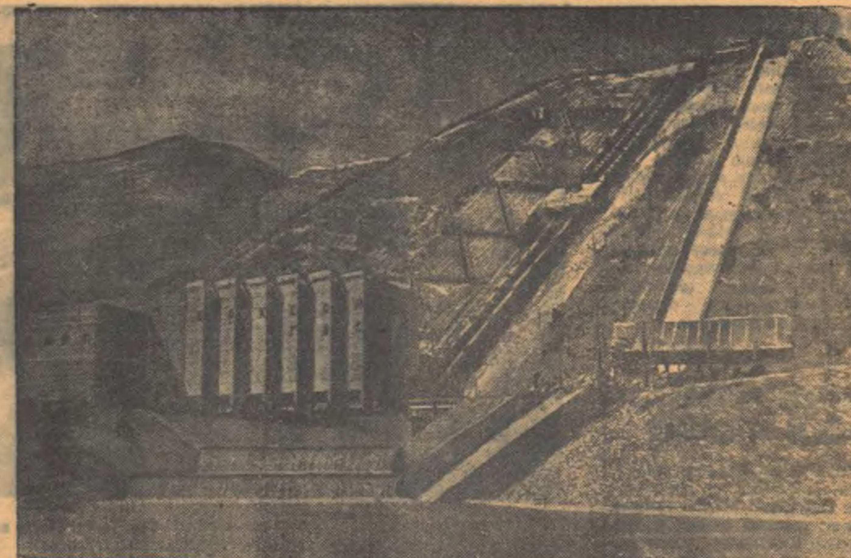
Наилучшее турбинного турки первой очереди Банасанской гидроэлектростанции. На снмке: общий вид Банасанской гидроэлектростанции, напорного трубопровода и водосброса.
