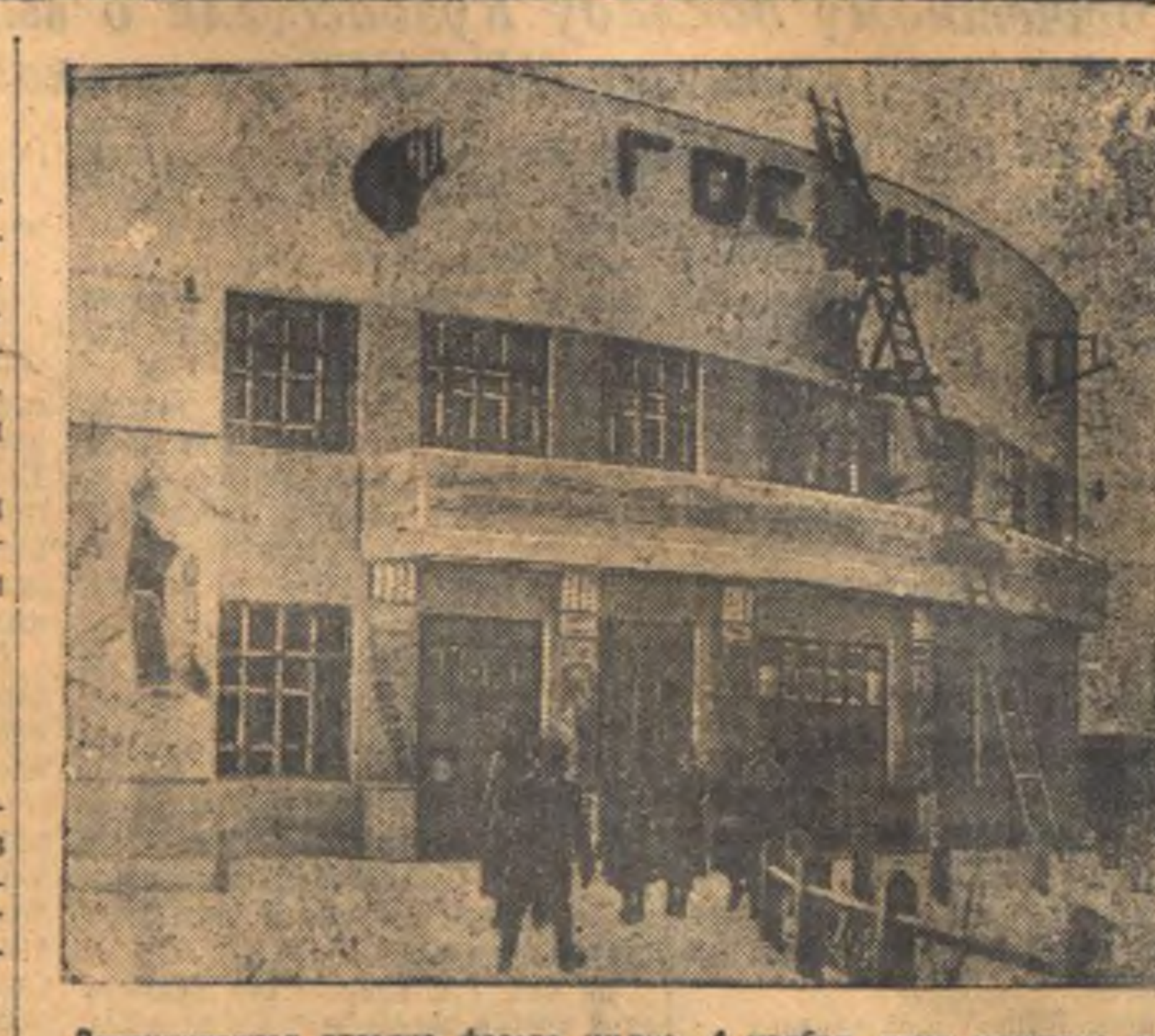
Заканчивается отделка фасада цирка. 4 ноября цирк начинает свои работы. (Фото М. Носкина).
