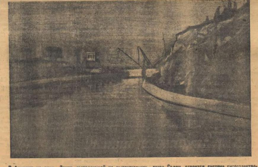
В Армении на реке Занги, вытекающей из высокогорного озера Севан, строится система гидроэлектростанций, общей мощностью в 800 тыс. киловатт. Первая станция этой системы — Канакирская — заканчивается строительством. На снимке: канал Канакирской ГЭС. (Союзфото).
