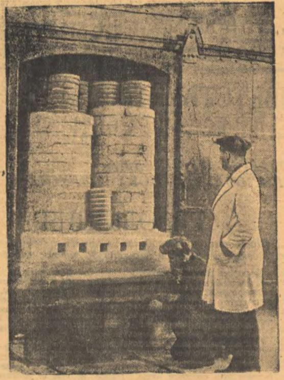
На Ленинградском образцовом заводе «Ильич» в цехе обжига построена первая в Союзе и самая мощная в Европе туннельная печь для обжига образцовых изделий. Работа туннельной печи равна работе 20 обычных периодических действий при вдвое меньшем расходе топлива. Производительность печи 10 вагонов шихтовых кругов в сутки. На снимке: выемка из агломерационных кругов из печи. (Союзфото).
