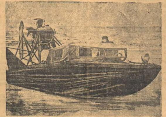
Арктические аэро-самы конструкторки инженера Л. В. Курчавского назвали прекрасные ходовые качества во время испытаний на Москва-реке. Самы приспособлены для движения по льду, снегу и по воде. Мотор в 100 лошадиных сил позволяет аэро-самым развивать среднюю скорость до 80 км. в час. На снимке: арктические самы-воздуход на льду. (Союзфото).
