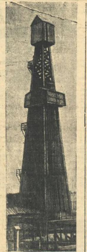
Разведочная партия «Восток-Нефть», обнаружившая на Средней Воле (в районе Сызрань, Куйбышевская обл.) нефтеносные горизонты. Скважина № 10, пробуренная на глубину 1100 метров, начала фонтанировать с суточным дебитом до 50 тонн высококачественной нефти.
