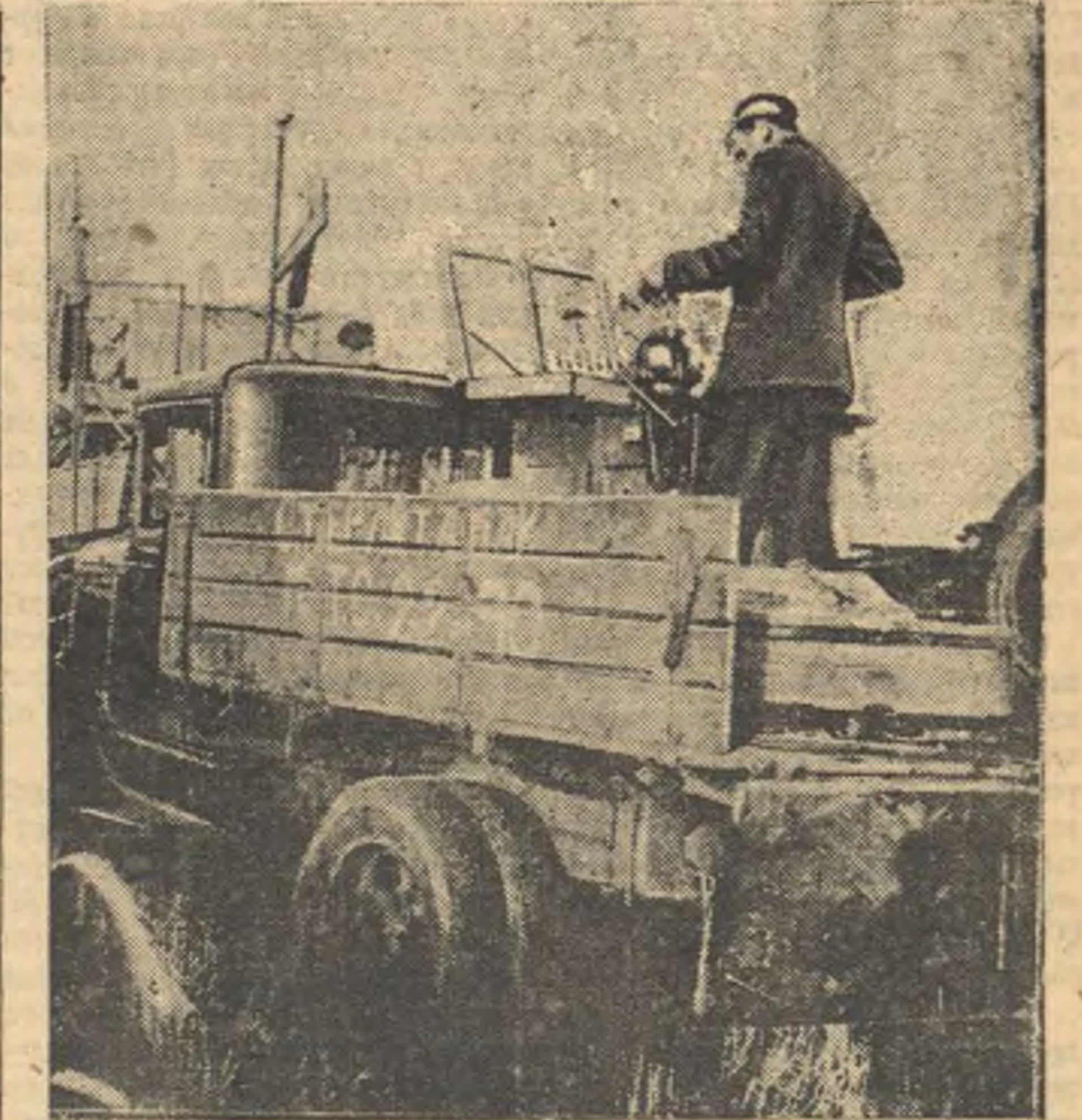
Стерлитамакской машинно-транторной станцией (Стерлитамакский район, Башкирия) организована передвижная мастерская для ремонта комбайнов и транкторов, работающих на уборке зерна. Мастерская снабжена запасными частями, инструментом и всем необходимым для текущего ремонта. На снимке: слесарь Мостя Тарасов обрабатывает в передвижной мастерской деталь комбайна. (Союзфото).
