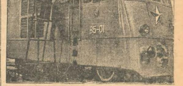
Коломенский машиностроительный завод имени В. В. Куйбышева заканчивает монтаж и сборку основных узлов опытного паровоза высокого давления обтекаемой формы. Этот паровоз даст большую экономию топлива. На снимке: паровоз высокого давления «Б5-01». Слесари-сборщики т.т. Н. И. Голубов и Н. Г. Федотов заканчивают отделку паровоза. (Союзфото).
