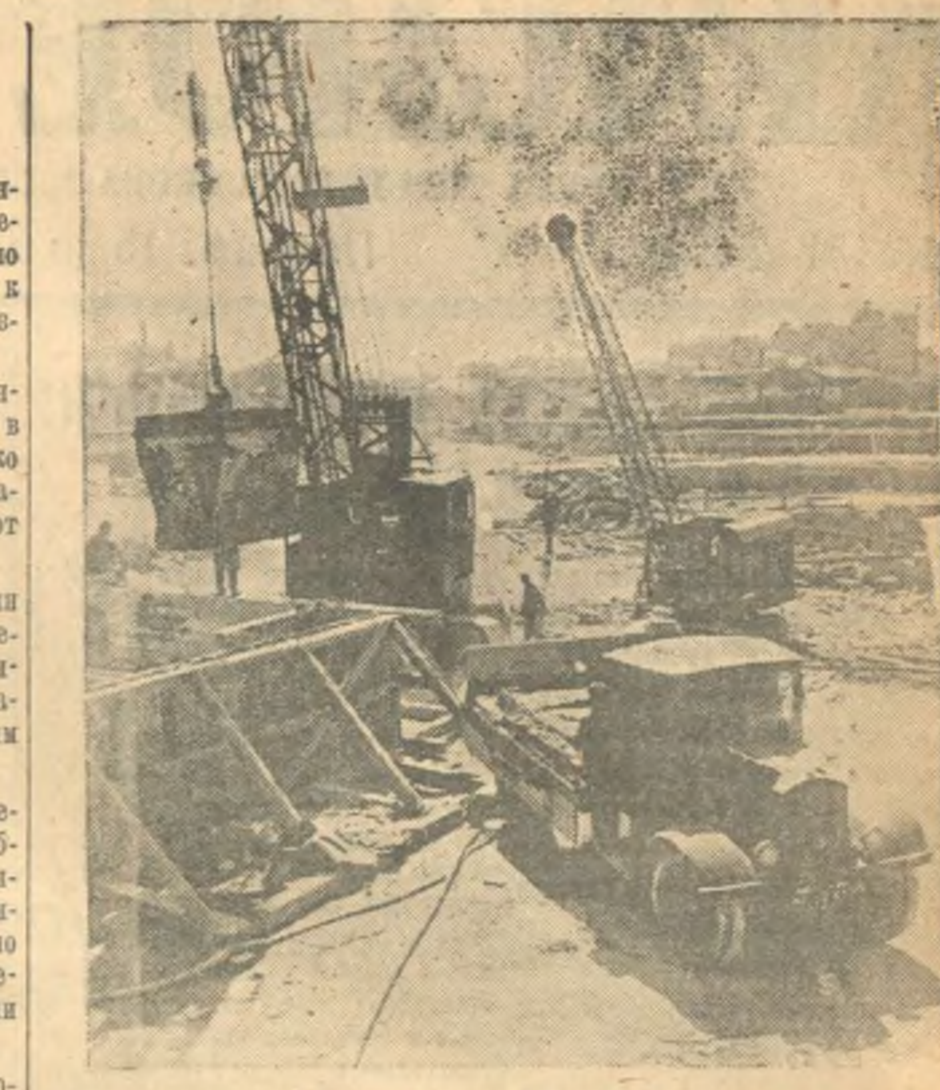
На строительстве Дворца Советов. На снимке: бетонирование фундамента.
