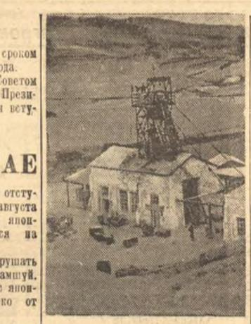
В конце июня на Шурабском угольном месторождении (Исфаринский район, Таджикская ССР) закончена и сдана в эксплуатацию новая шахта № 8. Ее проектная мощность — 500 тысяч тонн угля в год.
