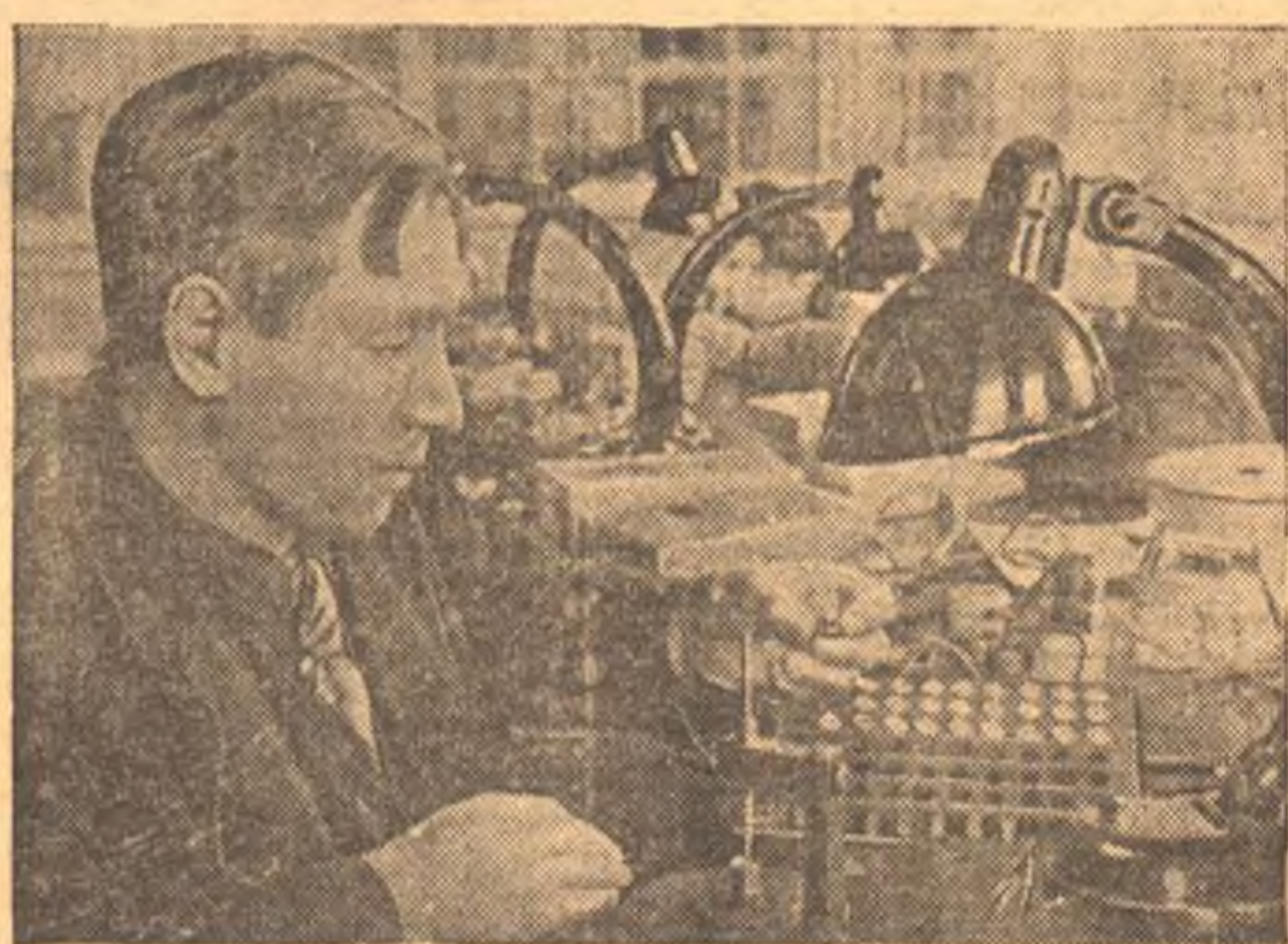
Мастер фильерного отдела завода «Платиноприбор» (Москва) П. И. Зезин разработал новый способ обработки фильера, при котором отпадает необходимость в применении дорогостоящих сверл, упрощается процесс шлифования фильера и вдвое увеличивается производительность труда. На снимке: П. И. Зезин за проверкой фильера. (Фото-кино ТАСС).
