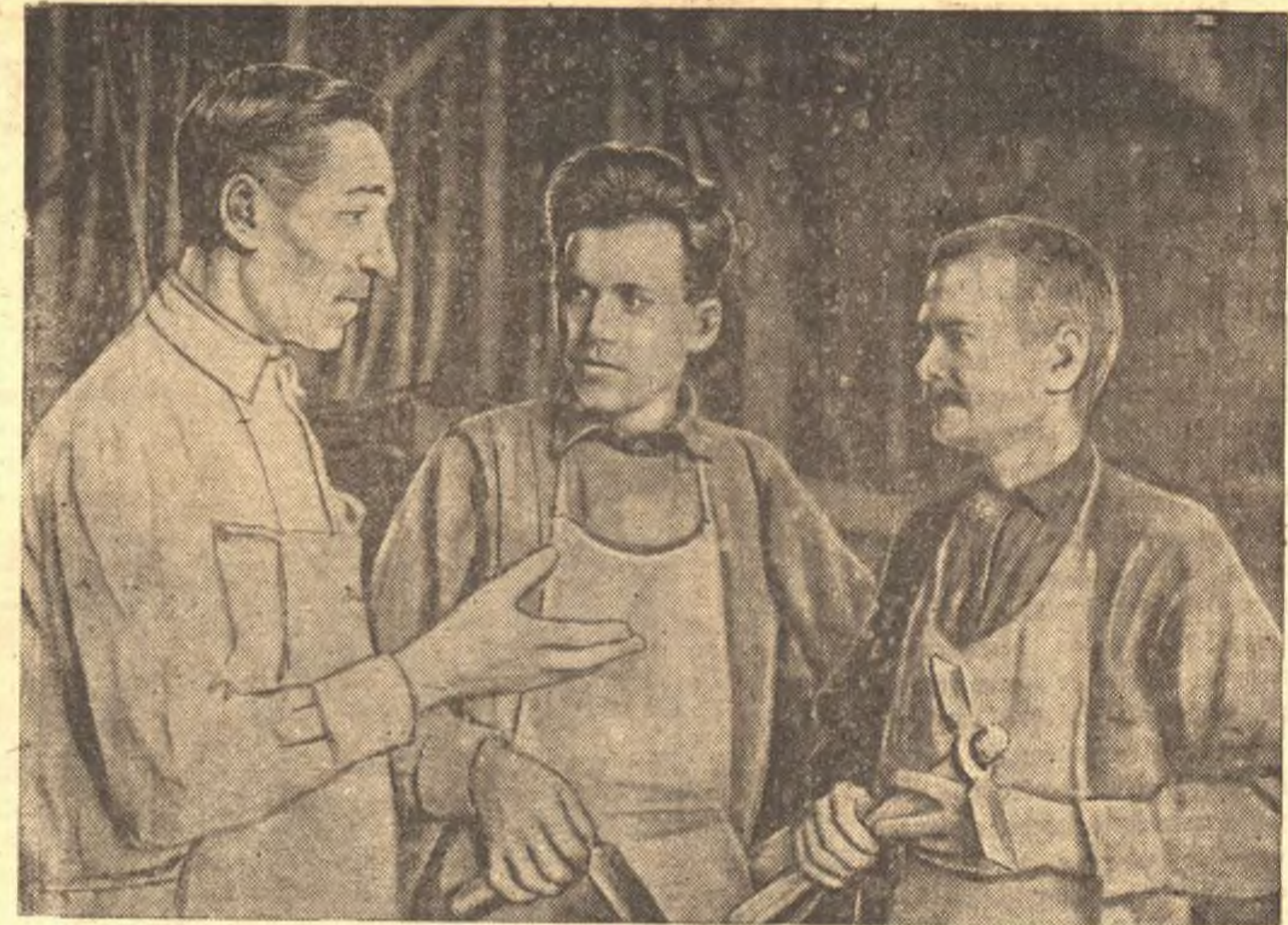
Стахановцы, строители ТЭЦ. На снимке (слева направо): тт. Линнев М. Н. — бригадир обмуровочной бригады и обмуровщики Усманов Х. С. и Ревин П. С., выполняющие нормы по обмуровке котла на 200 процентов. (Фото Хитриневича).
