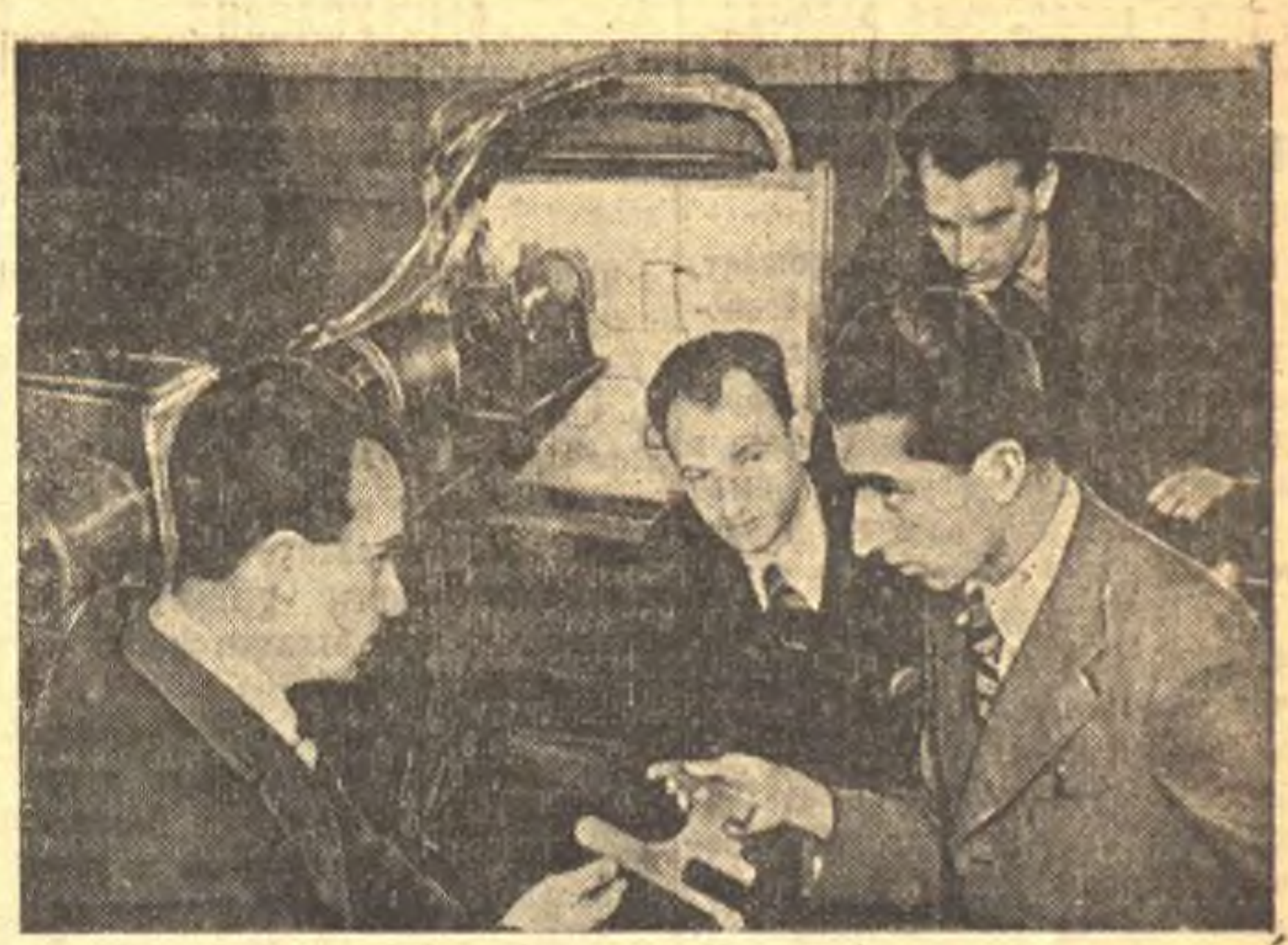
Начальник научно-исследовательской лаборатории орденского завода «Красный пролетарий» (Москва) В. С. Выхан сконструировал фотоэлектрический фрезерный автоматический станок, который производит изготовление сложных контурных металлических изделий (без участия человека), непосредственно по чертежу, вкладываемому в станок. В качестве основного управляющего органа в станке применен фотоэлемент. Внедрение таких станков должно повысить производительность в разнообразных отраслях машиностроения от 3 до 50 раз. Кроме того, в ряде производств сложный ручной труд заменяется машинной обработкой, а также сильно ускоряется технологические процессы. Сейчас лаборатория завода для ознакомления с конструкцией станка и обмена опытом посетит Москва и конструкторов московских предприятий. На снимке: (слева направо) В. С. Выхан и главный конструктор лаборатории завода «Красный пролетарий» И. М. Бердяев дают объяснения инженеру-комсомольцу Л. Л. Рейфман и мастеру П. П. Беспальченко (справа), посетившим 10 января лабораторию завода «Красный пролетарий». Фото-аппарат ТАСС.
