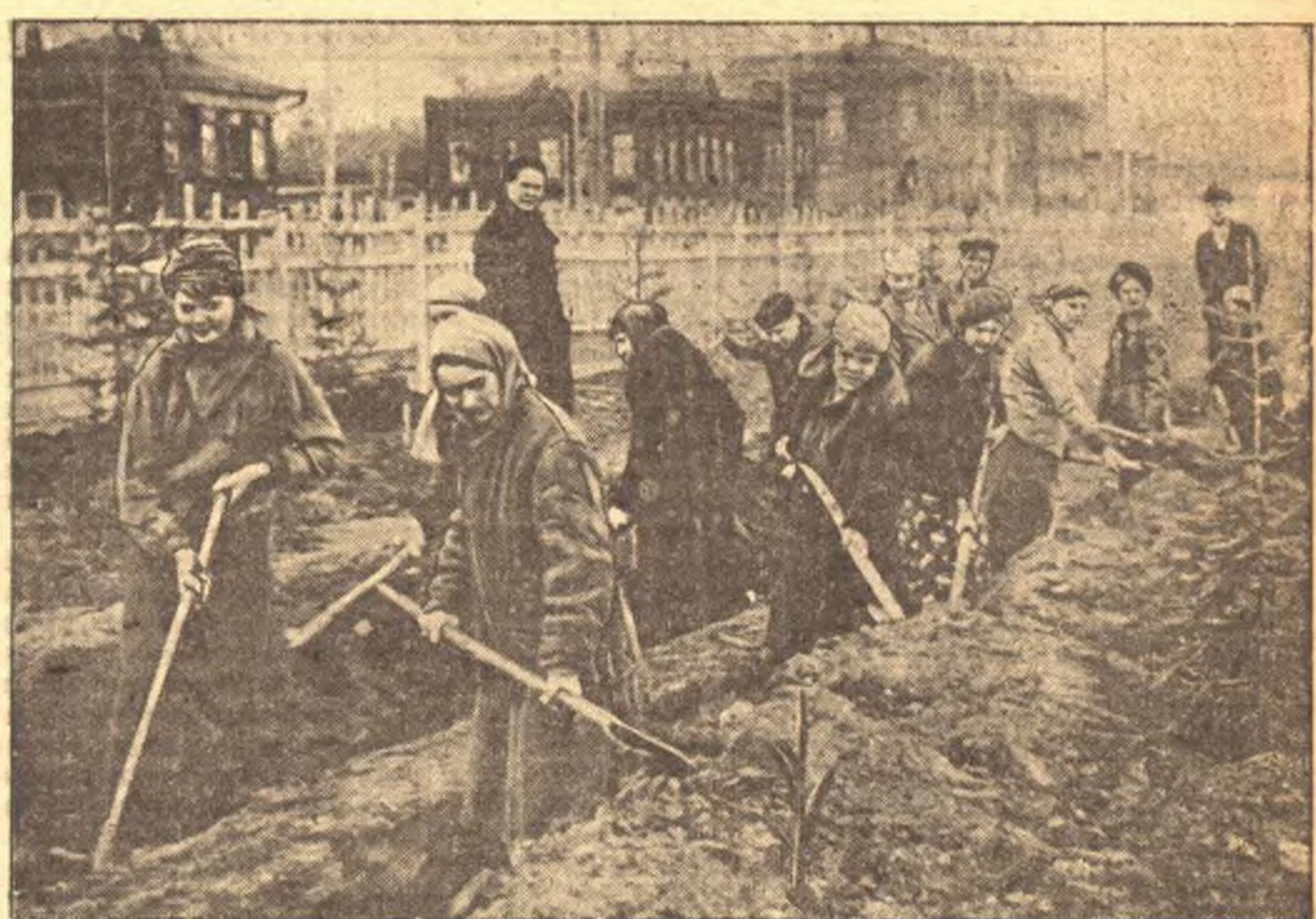
На строительстве парка культуры и отдыха в Вокзальном районе.
