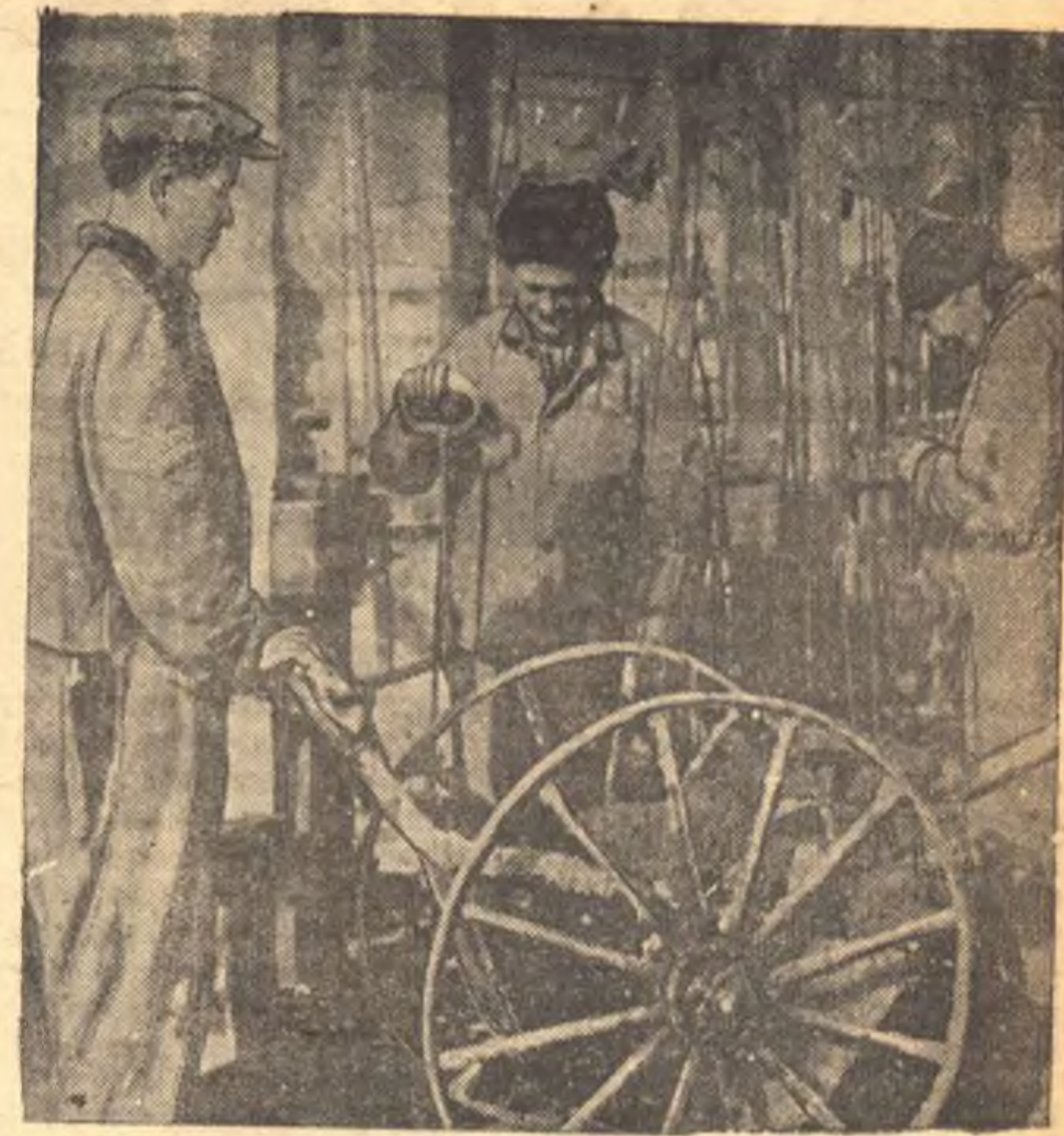
Лучшие бетонщики строительства Томского элеватора. На снимке: А. Савухин, П. В. Емельянов и Н. П. Лобанов, выполняющие задание до 140 процентов. Фото Хитричевича.
