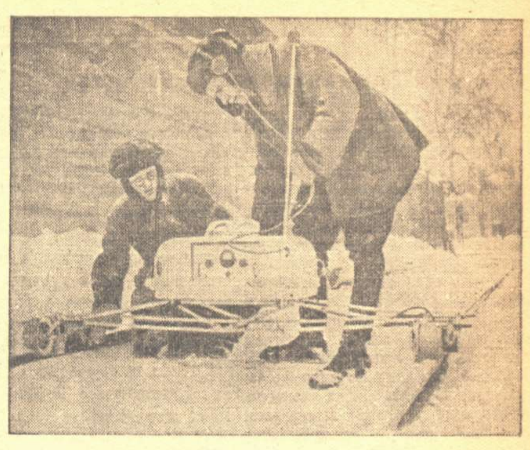
Научные работники физико-технического института (слева направо) Б. П. Кашкин и А. К. Куршев за испытанием дефектоскопа, специально изготовленного в мастерских института для Московского метро им. Кагановича. Фото Хитрищевича.
