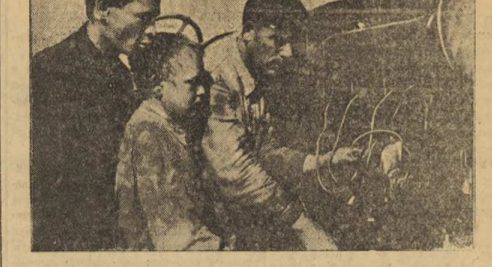
На снимке: бригады тракторного отряда Чилинской МТС коммунист Филипп Кузнецов обучает молодых трактористов правильной установке магнето. Фото Ф. Хитринович.
