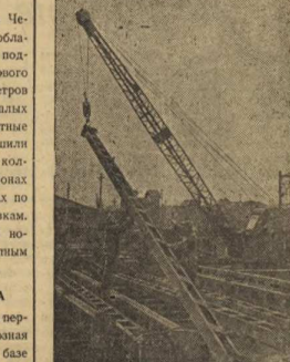
Установка металлических колон на восстановлении Елисвевского котельно-механического завода. (Фотохроника ТАСС).
