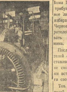
На восстановительной ремонтной организации Омского завода имени Январского восстания в большом цехе работают бригады, восстанавливая моторные машины с 40-летним производственным стажем тов. Горюхиным.
