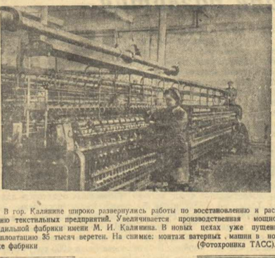
В гор. Калинин широко развернулись работы по восстановлению и расширению текстильных предприятий. Увеличивается производственная мощность прядильной фабрики имени М. И. Ульянина. В новых цехах уже пущены в эксплуатацию 35 тысяч веретен. На снимке: монтаж аппаратуры машины в новом цехе фабрики. 35 СКОРОСТНЫХ ПЛАВКОВ ЛЕНИНГРАД, 22 апреля. (ТАСС). Премьескому соренированию металлургии завода «Большевик» за последний семестр стали, а также здесь по инициативе сталеразливальщика, приняло широчайший размах. Вчера утром сталеразливатель Михаил Садовский в 4 часа 19 минут начал первую быструю разливку в 3 квадратных метра под давлением графика, превысив норму с 2,6 тонн с квадратного метра под давлением 2,6 тонн. Еще лучшие результаты достиг в дневной смене сталеразливальщик. Он пролил 82-ю тонну плавку за 9 часов 45 минут вместо 14 часов 20 минут и свил с квадратного метра под давлением 4,68 тонн металла больше нормы. За 20 дней апреля металлургия «Большевик» дала 35 скоростных плавок, сварила 630 тонн высоколегированной стали сверх двухдвухлетнего задания.
