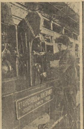
Киевский станкостроительный завод имени А. М. Горького выпускает новые сложные автоматические шестипильные токарные станки. На таком станке можно одновременно обрабатывать семь деталей. На снимке: стахановец сборщик завода Ф. Н. Макаров, выполняющий свыше двух годовых норм, за регулировкой станка-автомата. (Фотохроника ТАСС).
