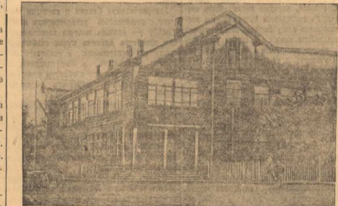
В этом здании размещены районный комитет партии, исполком районного Совета депутатов трудящихся и его отделы, редакция и типография районной газеты, райком комсомола. Вправо и влево от этого здания идут прямые широкие улицы с двухэтажными и одноэтажными постройками.
