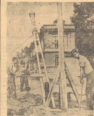
На снимке: бригада монтажников, работающая по Советской улице на установке опор для контактной сети трамвайной линии
