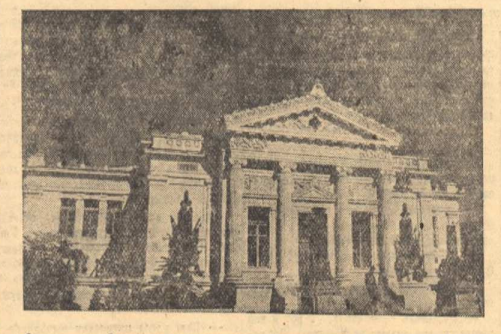
Севастополь. Закончено восстановление здания музея Севастопольской обороны (корпус был разрушен немцами во время войны). На снимке: здание музея Севастопольской обороны. Фотохроника ТАСС.
