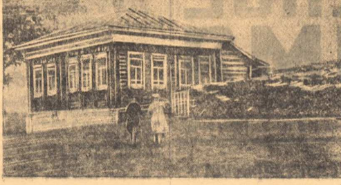
Школа колхоза «Новый быт». Туганского района, полностью построенной вступила в новый учебный год. Дров заготовлено 130 кубометров. Все голыно позволено к школьному занятию. Фото Л. Горданова.
