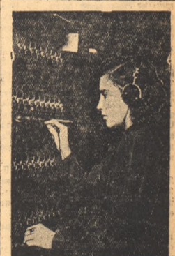
На новой Томской телефонной станции (АТС) заканчивается монтажные работы. Станция — важная точка связи. На снимке: инженер станции Т. Г. Орлова за проверкой работы аппарата. Фото Ф. Хитриниченя.
