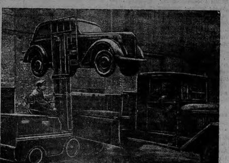
Московский машиностроительный завод имени Орджоникидзе Министерства транспортного машиностроения выпустил первую опытную партию автопогрузчиков — новая машина, заменяющая ручную работу на погрузке и выгрузке.
