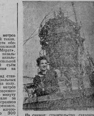
На снимке: строительство сахарного завода в Сиделе Гродненской области. На переднем плане — бригадир И. Григорьев.
