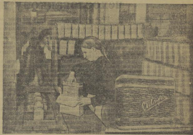
Томский радиозавод. В конце декабря прошлого года в цехе сборки смонтирован новый ленточный конвейер. С пуском конвейера количество работников, занятых в сборке, сократилось на семь человек. Сейчас с конвейера сходит в смену сотни готовых динамиков «Сибирь».
