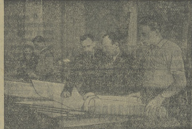
Коллектив московского трансформаторного завода имени В. В. Куйбышева поручено изготовить уникальные трансформаторы для новых волжских гидроэлектростанций — гигантов. На заводе создано специальное проектное бюро, в лаборатории ведутся исследовательские работы по испытанию материалов.
