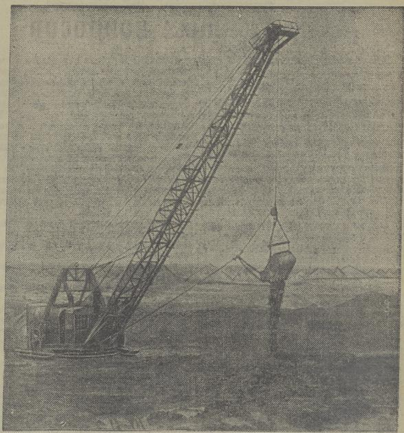
Строительство Волго-Донского канала оснащено передовой отечественной техникой. Здесь работают мощные шагающие экскаваторы, земляные скреперы, бульдозеры, скреперы и много других механизмов. На снимке: шагающий экскаватор ЭШ-1 на выемке грунта. (Фотохроника ТАСС).
